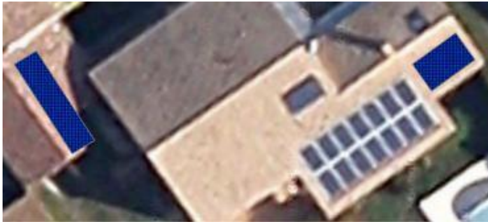
DP-7 ajout de 2 groupes de 3 modules en complément d'une ancienne installation de vente
